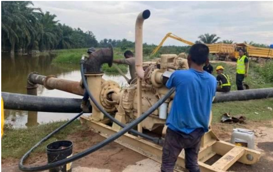
Pemasangan pam di salah satu lokasi banjir di Kuala Selangor.
